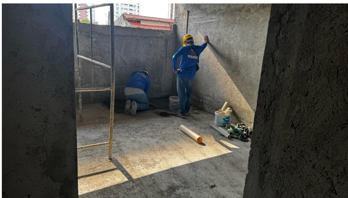
Figura 18. Execução de impermeabilização no piso dos banheiros coletivos.
