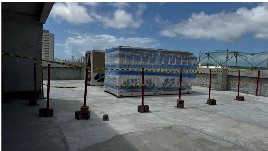
Figura 17. Execução de proteção mecânica para a manta na cobertura.
