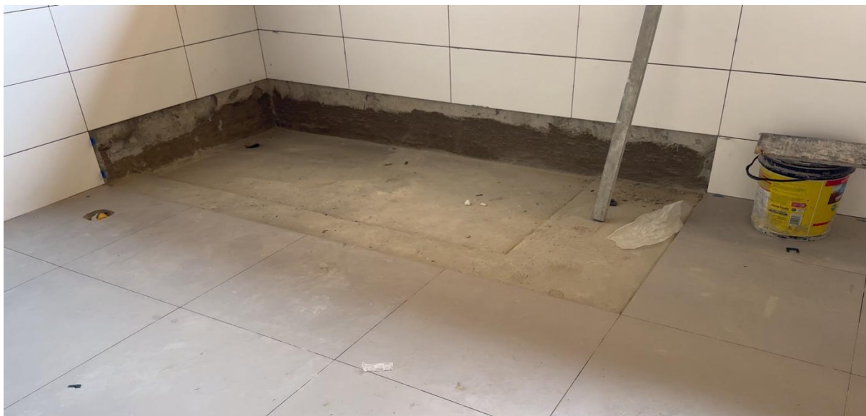
Figura 8. Assentamento do piso porcelanato nos banheiros coletivos do pavimento semienterrado 1.
