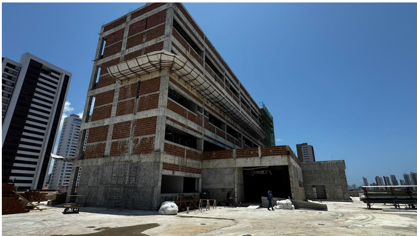
Figura 1. Visão geral da obra.
