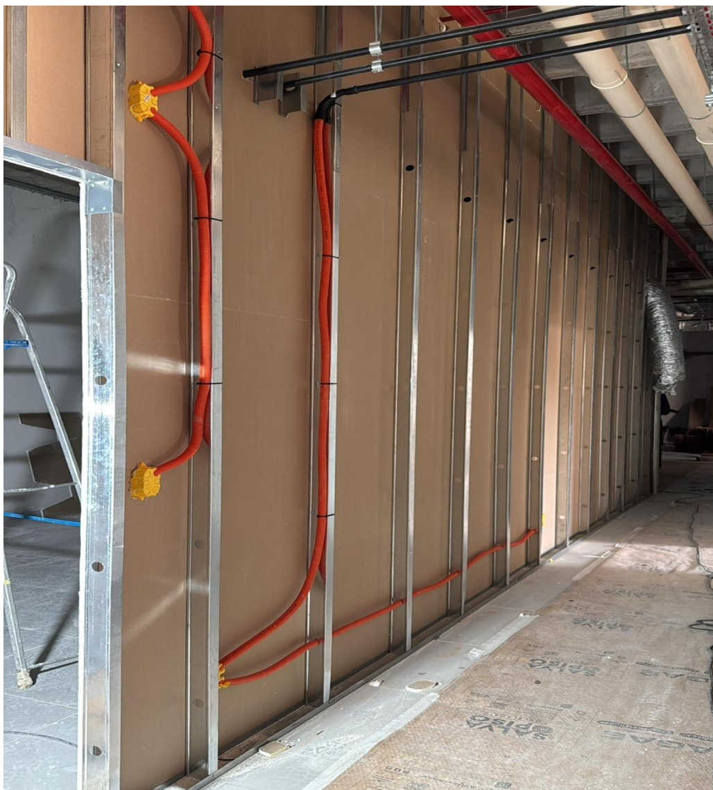
Figura 21. Instalação de conduites e caixas de tomadas.
