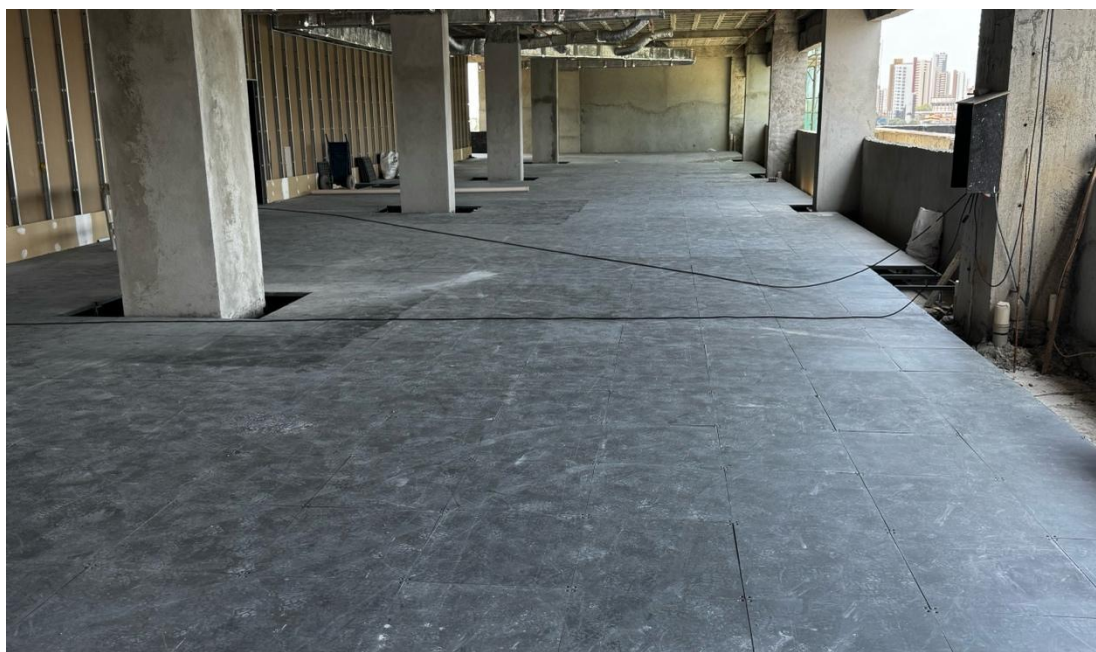
Figura 11. Instalação de piso elevado no primeiro pavimento.
