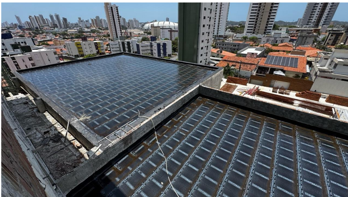
Figura 15. Execução de manta asfáltica 4mm na cobertura.
