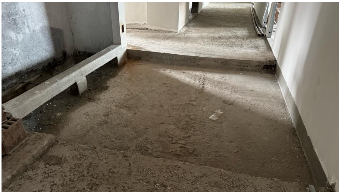
Figura 7. Concretagem do contrapiso com isopor no corredor do primeiro pavimento.
