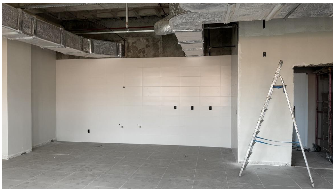
Figura 24. Instalação de tubulação para o sistema de exaustão da copa e restaurante no pavimento semienterrado 1.
