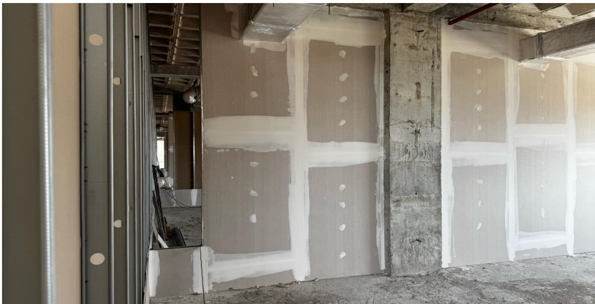
Figura 6. Instalação de paredes Drywall no segundo pavimento.
