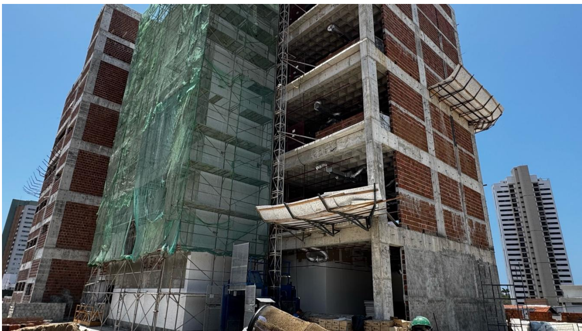
Figura 5. Caixa da escada com a alvenaria dupla finalizada.
