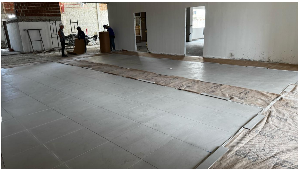
Figura 9. Assentamento do piso porcelanato na recepção do pavimento térreo.
