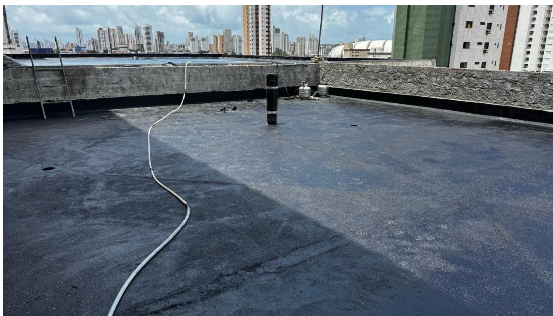
Figura 16. Execução de primer asfáltico sobre piso regularizado.
