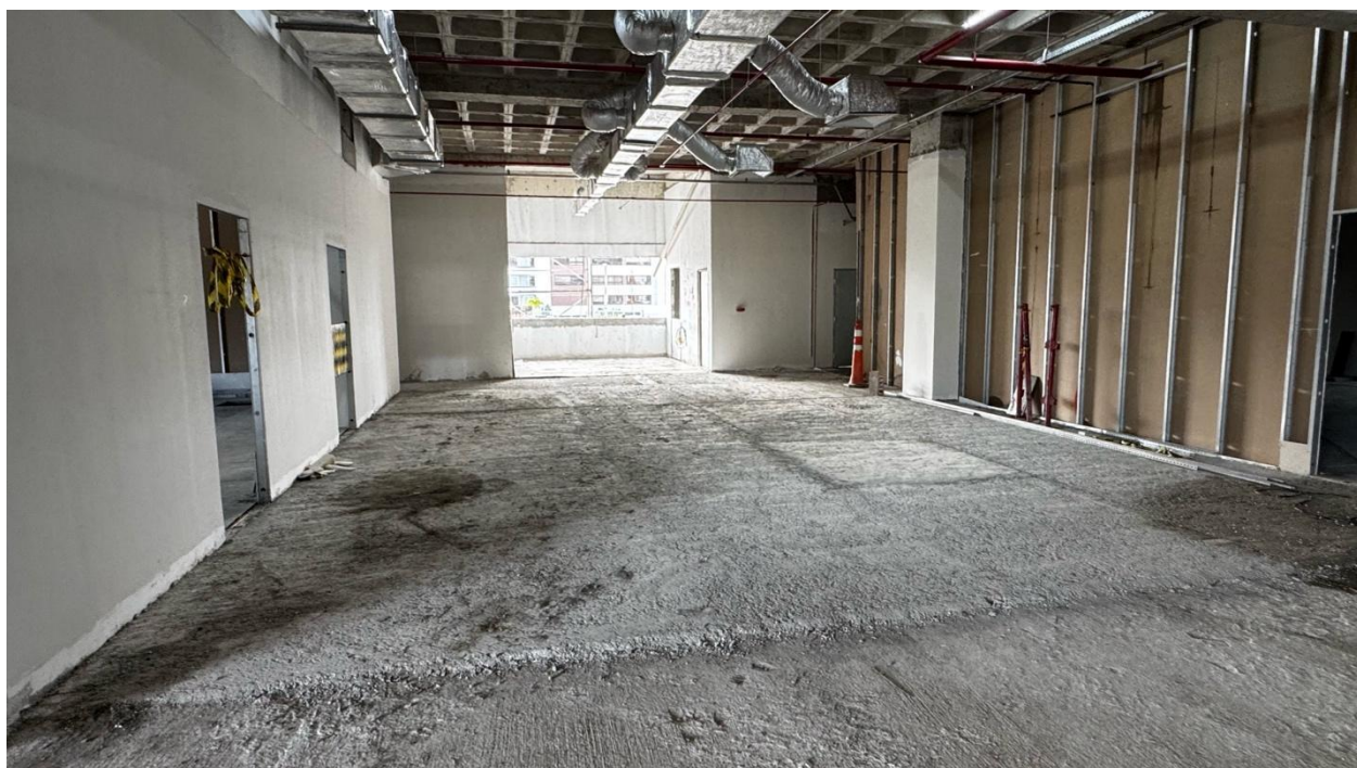
Figura 23. Instalação de tubulação dos ares-condicionados no pavimento térreo.
