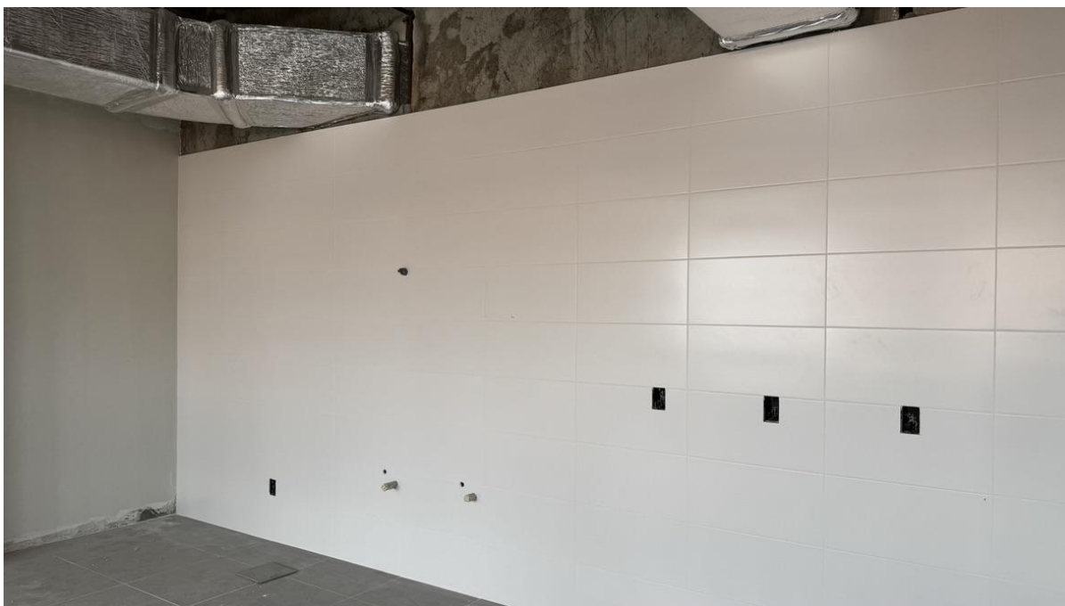
Figura 12. Assentamento de cerâmica nas paredes da copa do pavimento semienterrado 1.
