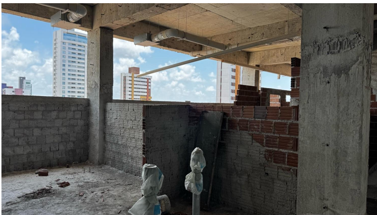
Figura 3. Elevação das alvenarias dos banheiros coletivos no quarto pavimento.
