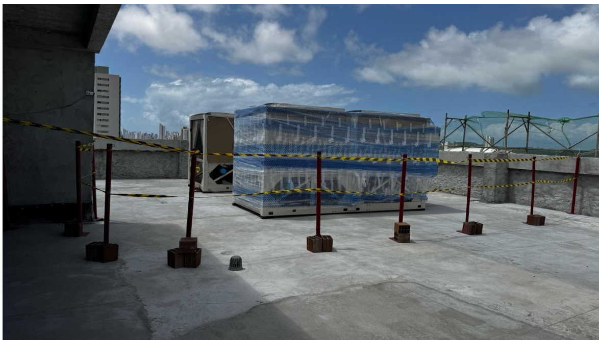
Figura 22. Instalação dos chillers de ar condicionado na cobertura da edificação.
